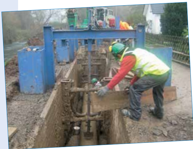
Aufwändiger Kanalbau In den Schlämmen
